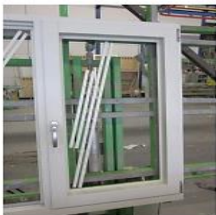
1. Draaikiepraam in gesloten stand
