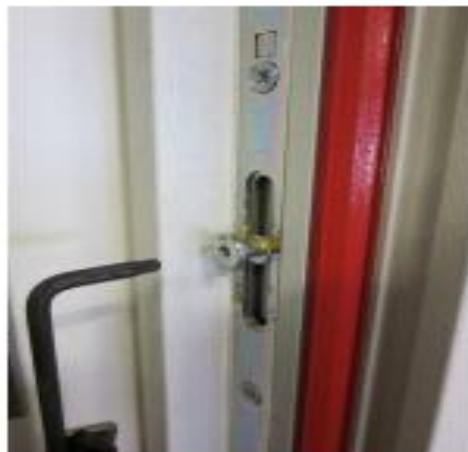
14. Met inbussleutel boutje naar links of rechts draaien
