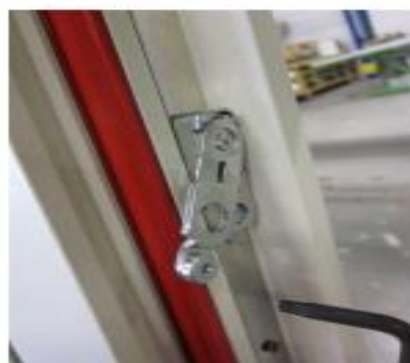
12. Met inbussleutel boutje naar links of rechts draaien
